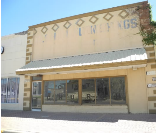
Photo 17 – 214 S. Texas Ave.
