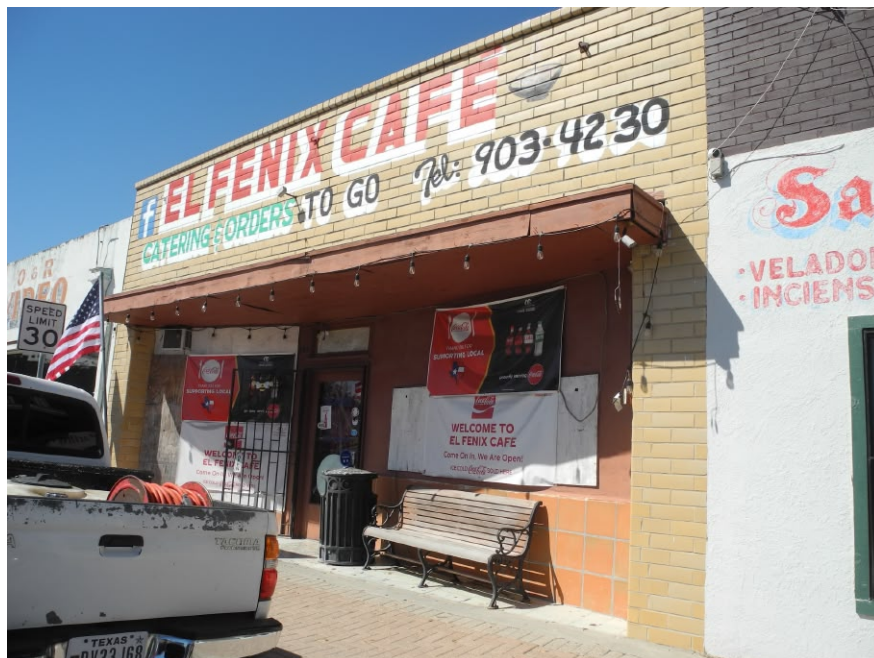
Photo 19 – 126 N. Texas Ave.
