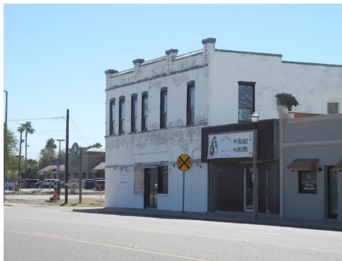
Photo 16 – 102 N. Texas Ave.
