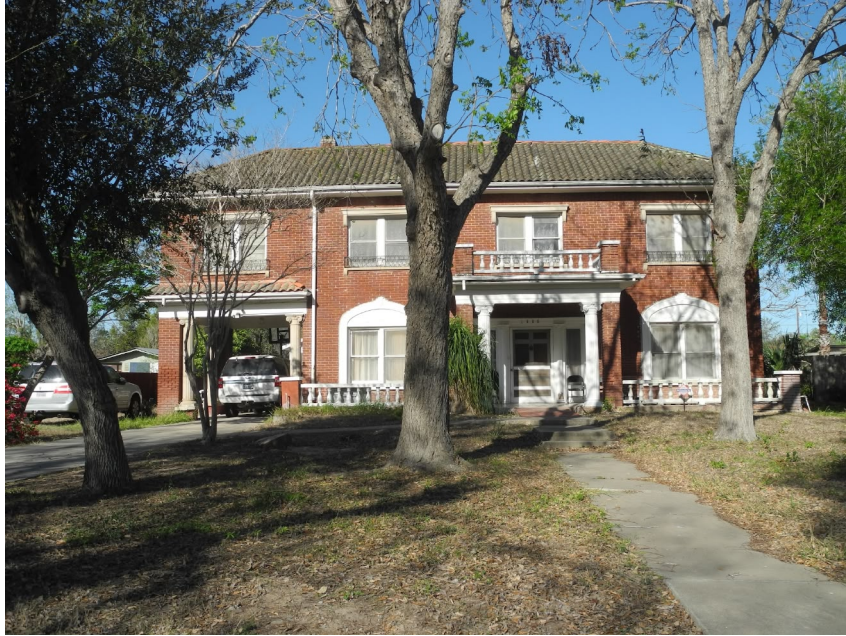
Photo 33 – 1509 S. Ohio Ave.
